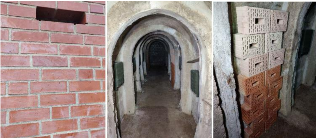
Abbildung 1: Gemauerter Einflug zum Quartier (links), Blick in den Kellergang (Mitte), aufgeschichtete Hohlblocksteine (rechts). Photos: Gloza-Rausch.
